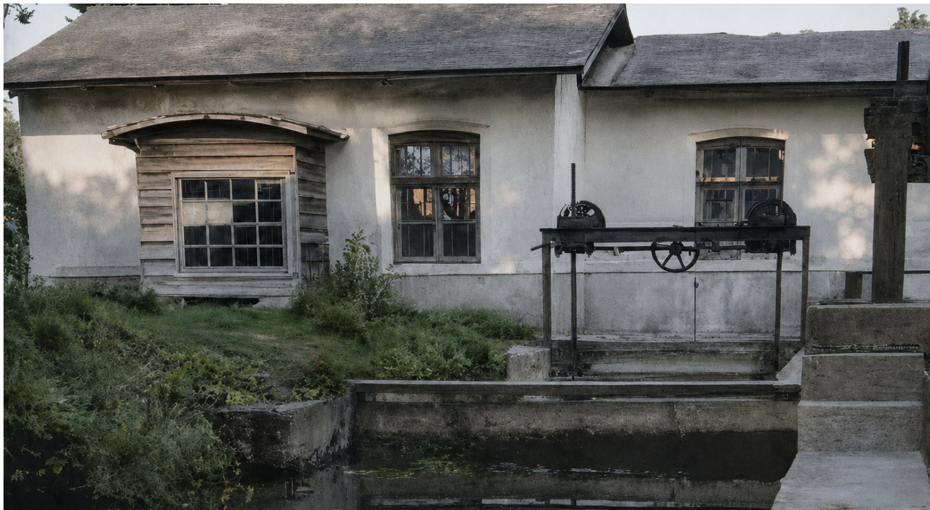
Instalación vinculada al aprovechamiento hidráulico. La central se encontraba río abajo del puente, separada del edificio principal del molino.
